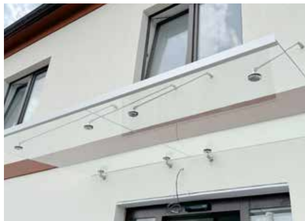
zastřešení vchodu | Obecní úřad Sobířňov
