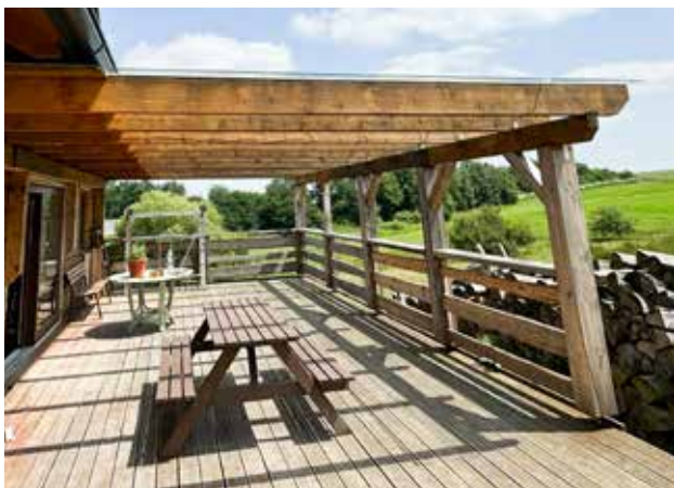
zasklení pergoly u srubu | Jihlava
