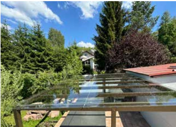
zasklení pergoly nad bazénem | Rudník
